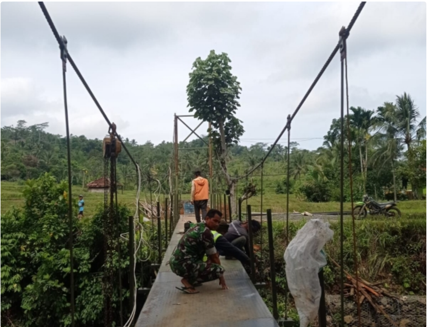
Kpt Arm Witono: Pengerjaan Jembatan Gantung Sudah 80%
